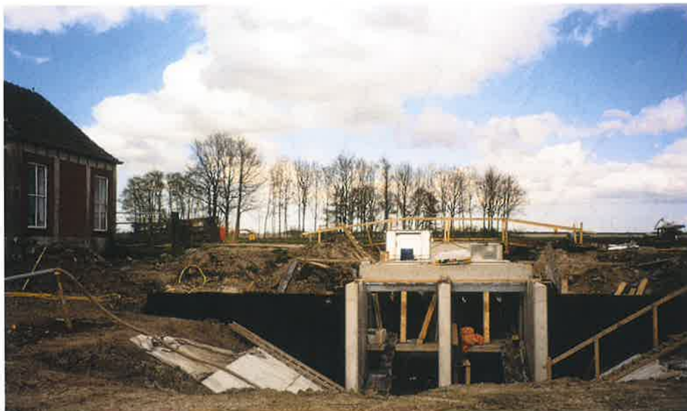
Het gemaal in aanbouw. Het bedieningspaneel komt in het oude gemaal te staan
