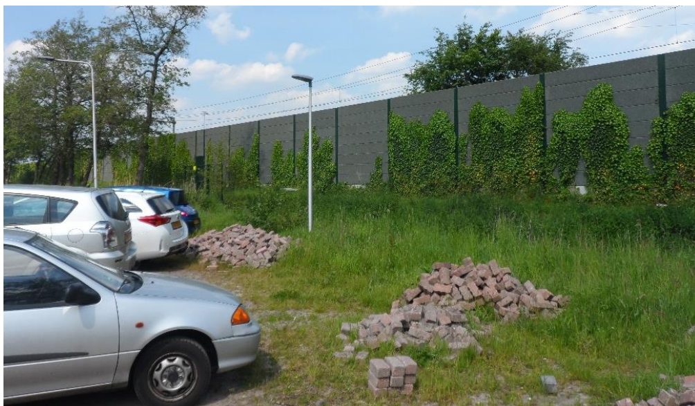
Geluidschermen langs het spoor aangelegd in 2018 ter hoogte Scharlakenbos
