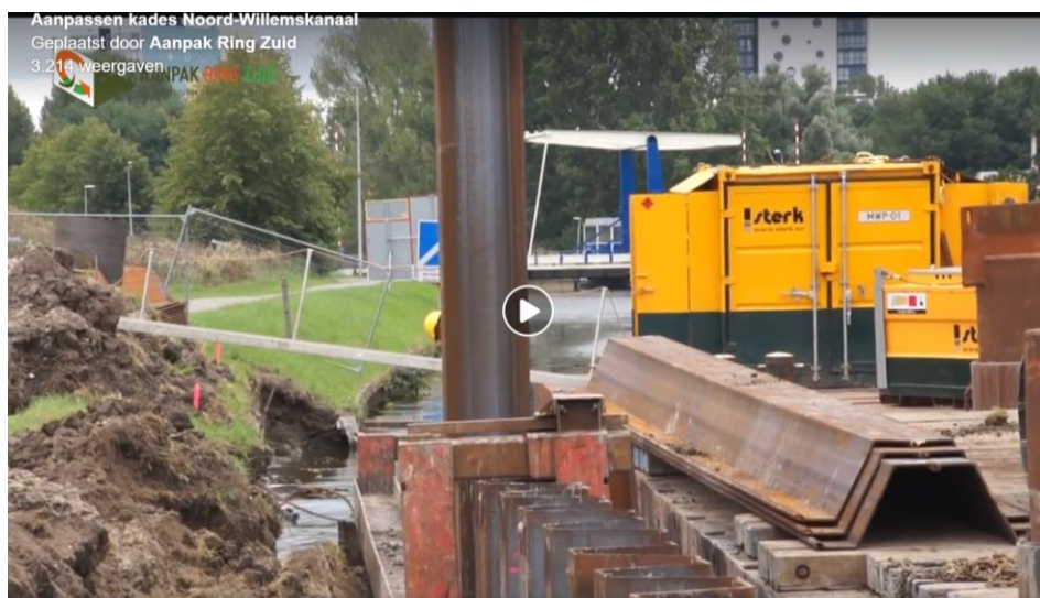
Grasoever worden vervangen door harde stalen damwanden
