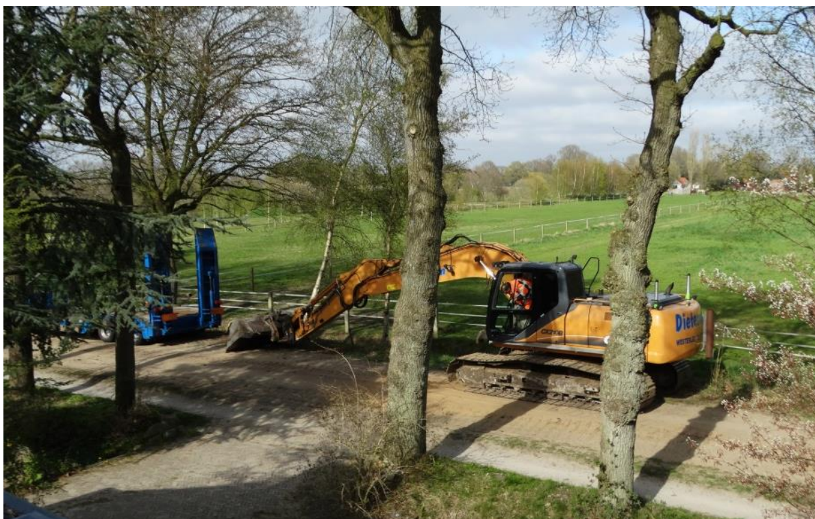
Onderhoud zandweg met dragline
