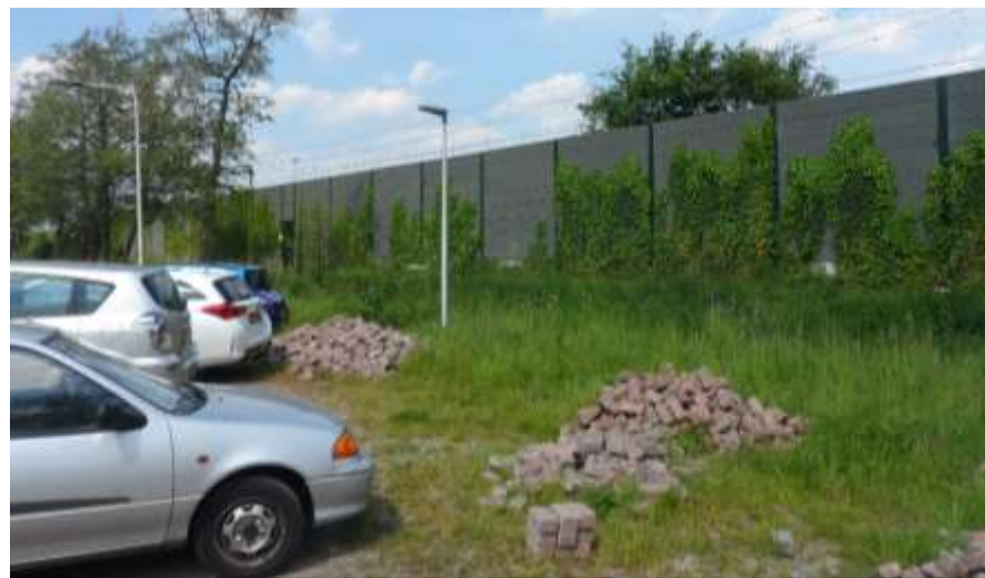
Geluidsschermen langs het spoor aangelegd in 2018 ter hoogte Scharlakenbos
