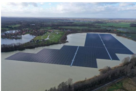
In Tynaarlo is een drijvend zonnepark gerealiseerd op de voormalige zandwinplas. Willem Braam
