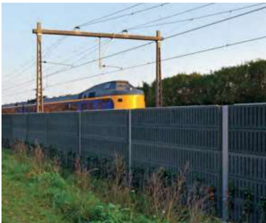
Geïntegreerde zonnepanelen op geluidschermen
