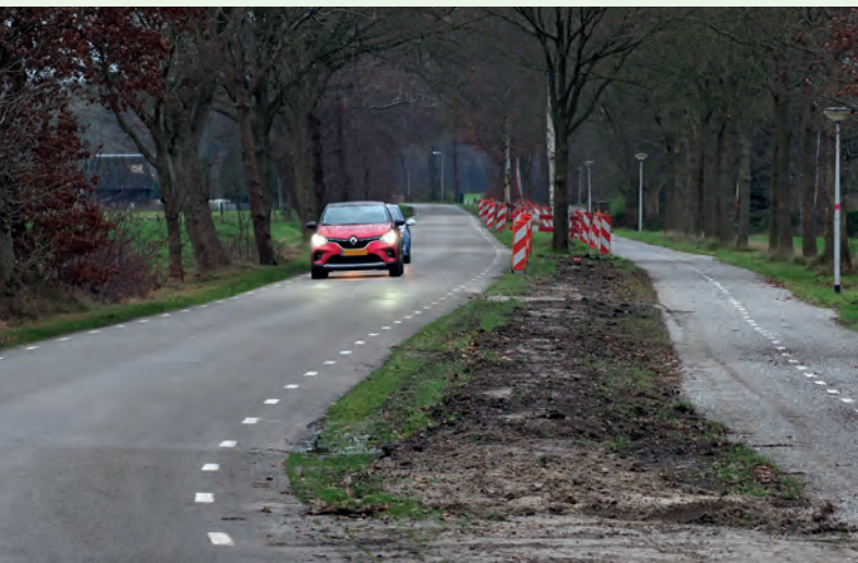
Aanleg van glasvezel.
