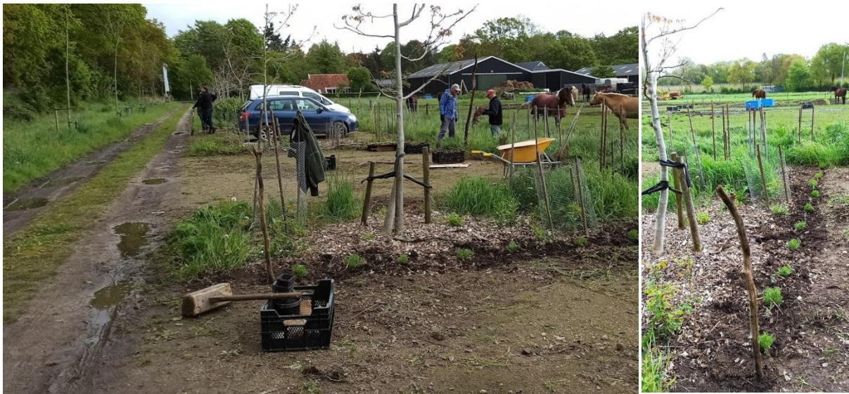
5 Aanleg parkeergelegenheid in ecostyle
